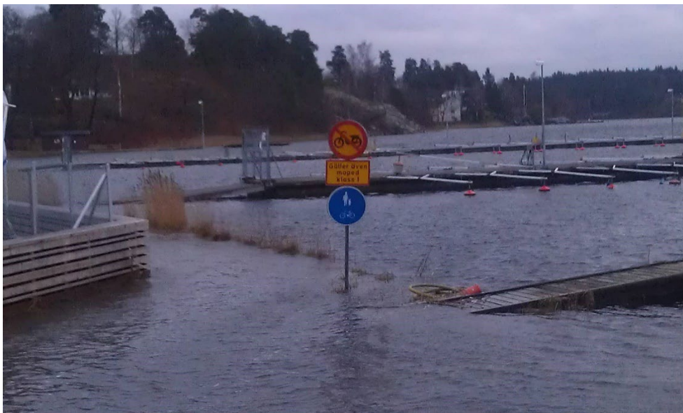
Figur 4, översvämningsskydd vid Nora strand.
