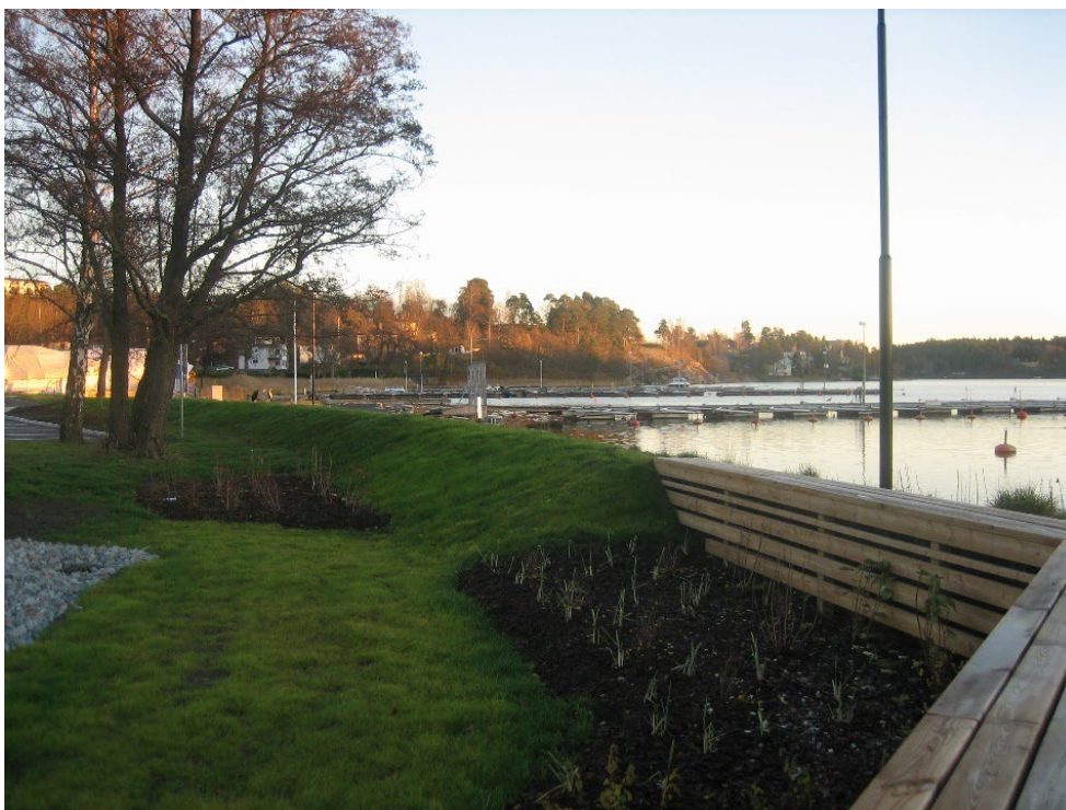
Figur 13 Översvämningsskydd vid Nora strand
