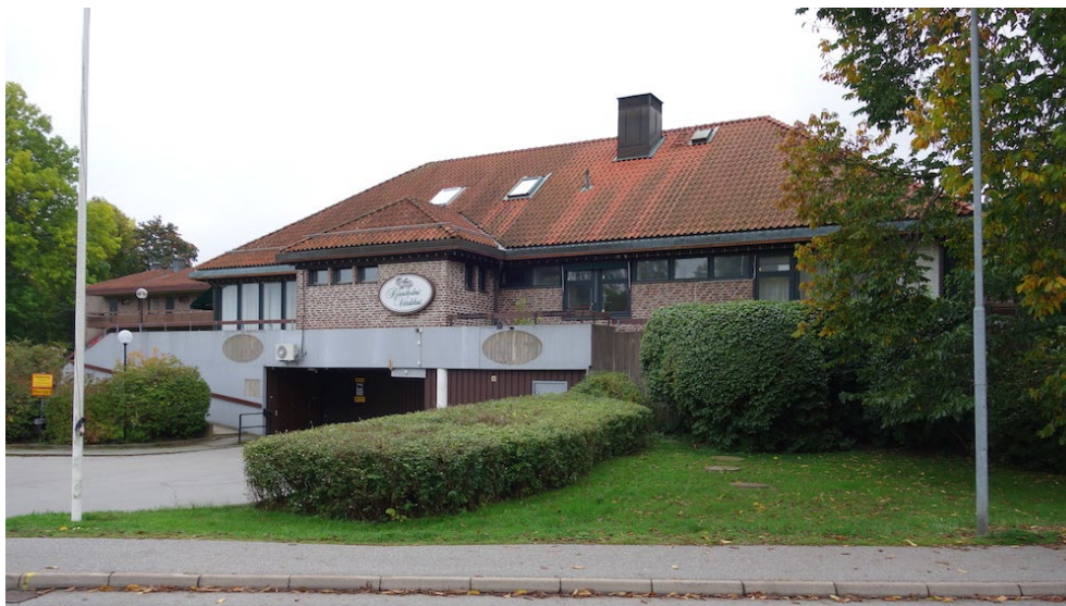
Vårdshusets framsida mot Vendevägen, med anläggningens underliggande garageinfart, med 1980-talets tillbyggnad ovanpå. Den blågrå målningsfärgen på den ursprungligen råa betongen är sekundärt tillkommen. I övrigt ser byggnaden ut som den gjorde när den uppfördes.
