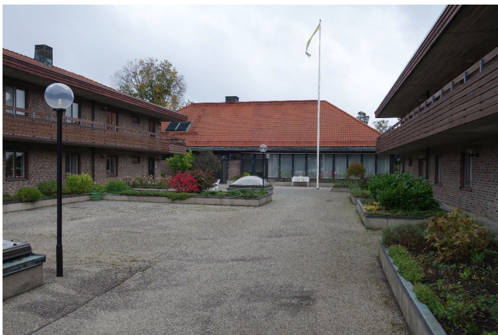
Gemensamhets-/vårdshusbyggnadens fasad in mot anläggningens gemensamma torgyta hösten 2020.
