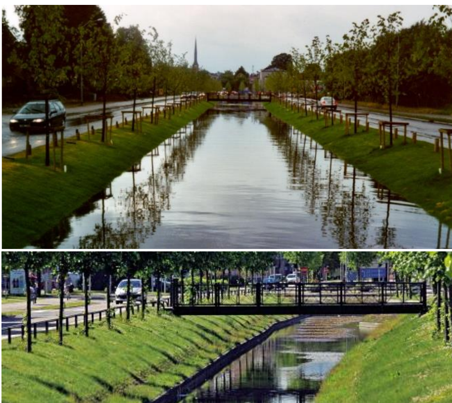
Figur 5. Dagvattenkanal i Växjö, Linnégatan vid höga flöden (överst) och vid låga flöden (nederst) 2 .
