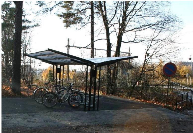
Cykelparkering vid Mörby station med väderskydd och möjlighet att låsa fast ram.
