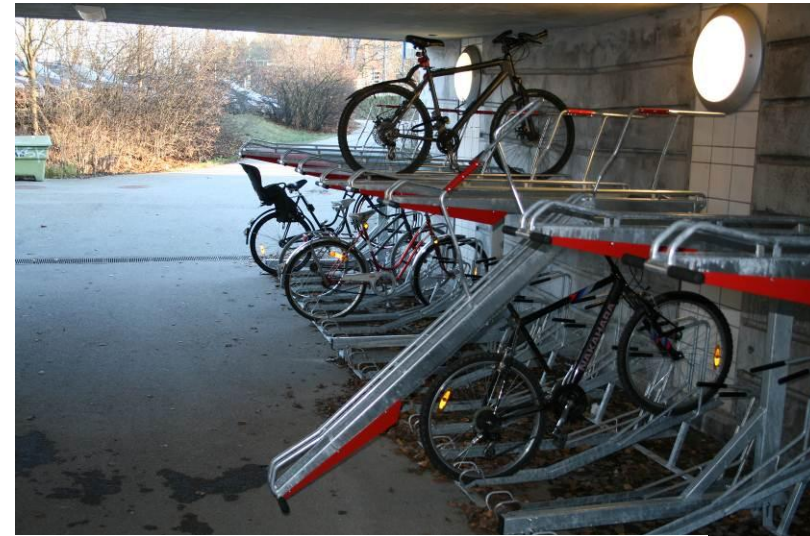
Cykelparkering vid Djursholms Ösby station med två våningar, väderskydd och möjlighet att låsa fast ram.
