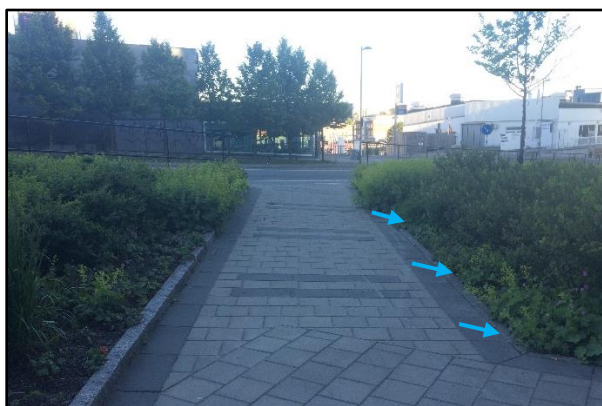
Bild 8. Exempel på ytlig avvattning av gångväg skevad till nedsänkt regnbädd med kantsten utan visning.
