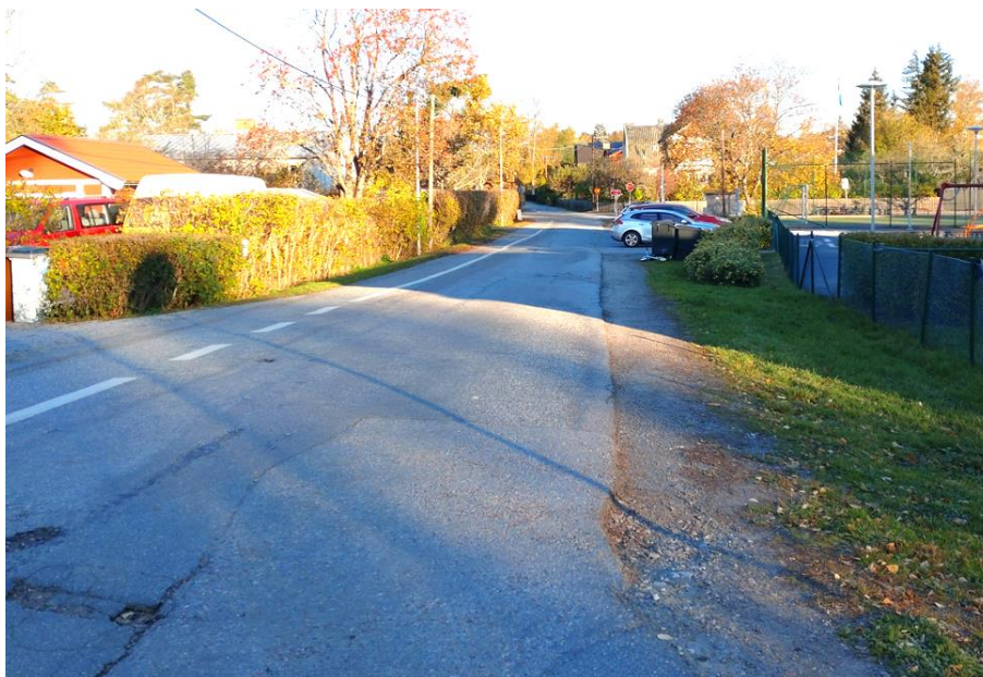
Bild 6 Den uppkörda gräskanten längs med Västerängsvägen visar på att många kör sina fordon vid sidan av vägen. Den målade gångbanan syns till vänster i bild.
