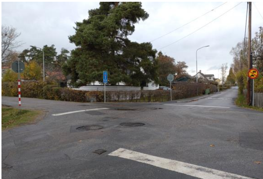
Bild 9 Korsning 1 med flervägs stopplikt och ett farthinder i den norra anslutningen.
