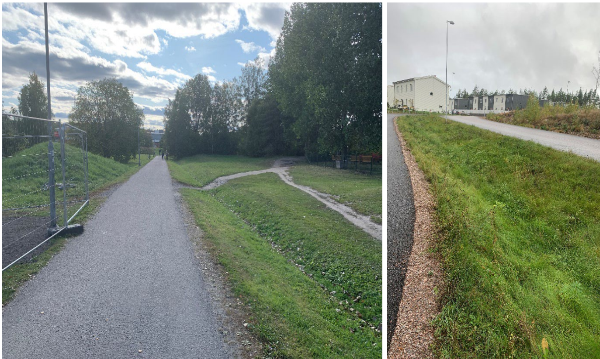
Figur 8. Diken längs med vägar och gång- och cykelbanor är ett bra sätt att rena, fördröja och avleda dagvatten. Exempelbilder från Vallentuna och Karlstad. (Foto: Bjerking).
