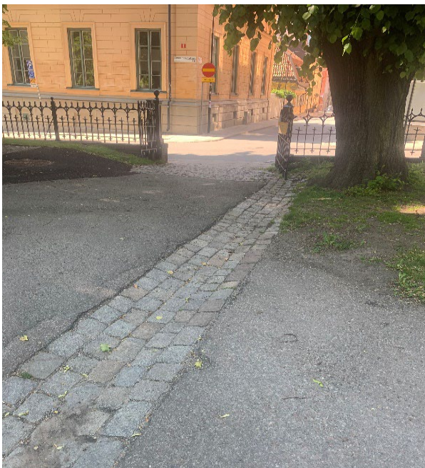
Figur 15. Exempelbilder på stuprörsutkastare och rännदार från Stockholm och Malmö. (Foto: Bjerking).
