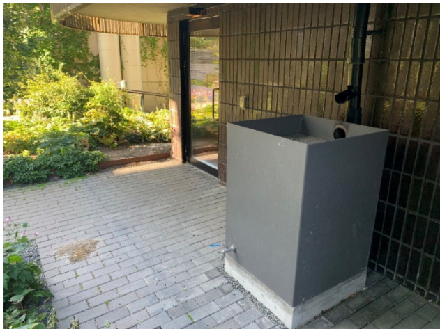
Figur 17. Regnvattentunna som utformats med tappkran kan användas för bevattning på kvartersmark i Norra Djurgårdsstaden. (Foto: Bjerking).
